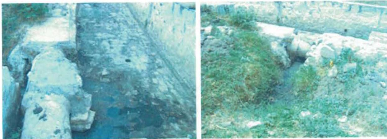
Figura 4. 21 – Emissário de esgoto em manilhas de concreto simples, danificadas, poluindo o solo. Foto: Projeto de Esgotamento Sanitário, PM Santa Luzia, 2009.
