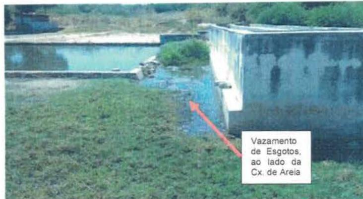
Figura 4. 32 – Vazamento de esgotos na ETE, ao lado esquerdo da Caixa de Areia. Foto: RDG,2016.
