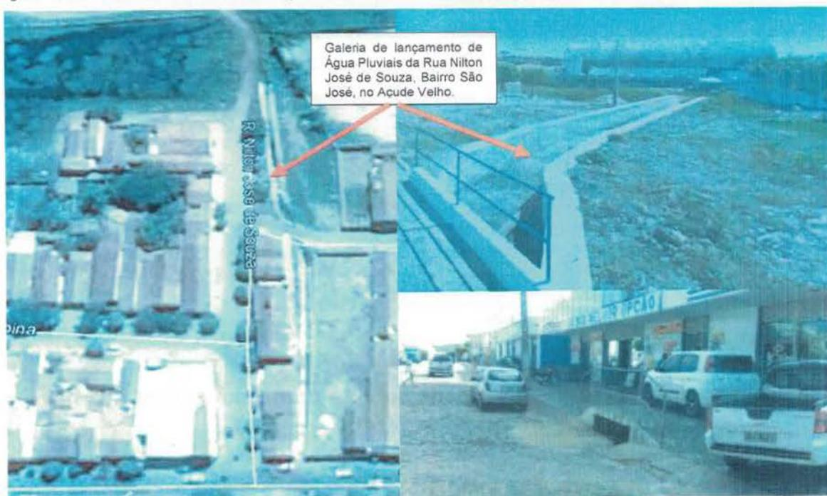
Figura 4. 36 e Figura 4. 37 – Trechos de canal de águas pluviais que deságuam no Açude Velho (Pe. Ibiapina).
