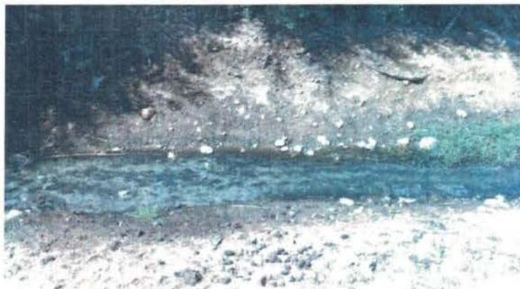
Figura 4. 33 – Vazamentos de esgotos na ETE, ao lado direito da primeira Lagoa Anaeróbia. Foto: Weyne,2016.
