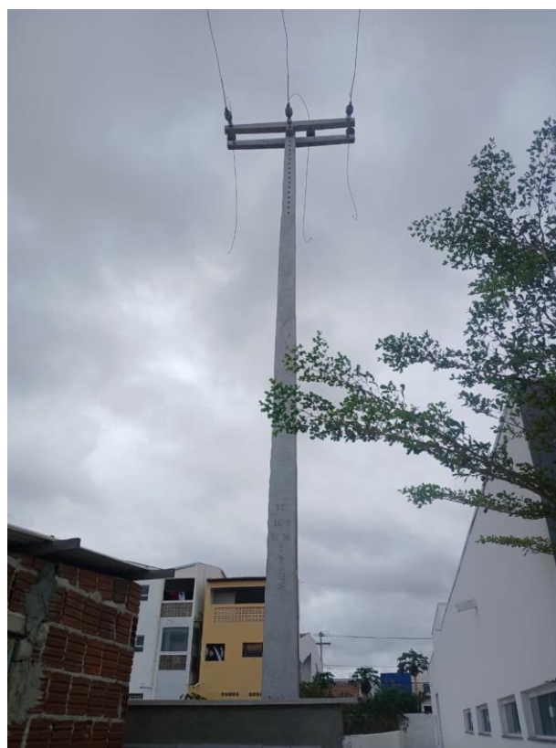
IMAGEM 03: CONDIÇÕES ATUAL DO EMPREENDIMENTO
